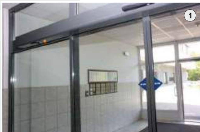
2. Zádveří je vytvořeno vnější a vnitřní prosklenou stěnou s automatickými dvoukřídlými posuvnými dveřmi. Čtečka čipů je umístěna již u prvních, vnějších dveří. Před nežádoucím vniknutím cizích osob je tak chráněn celý objekt, včetně zádveří.
