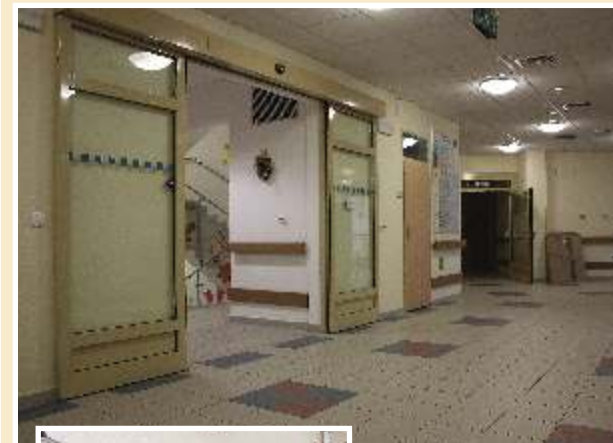
V interiéru instalovány posuvné pohony s dveřními křídly v požární úpravě (nahofe). V hlavním vstupu posuvné automatické dveře s pevnými bočními díly s povrchovou úpravou imitace dřeva (vlevo).
