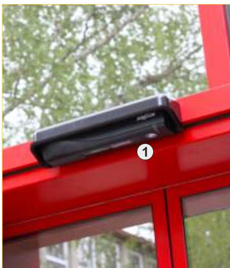
Kombinované aktivační čidlo, instalované na fasádě budovy, chráněné povětrnostním krytem.
