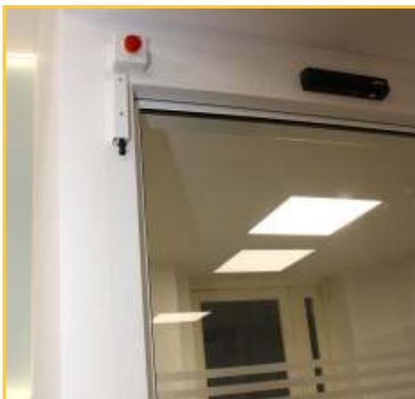
*Příklad externího umístění tlačítka nouzového otevření a táhla k uvolnění elektrozámku - z opačné strany pohonu.*
