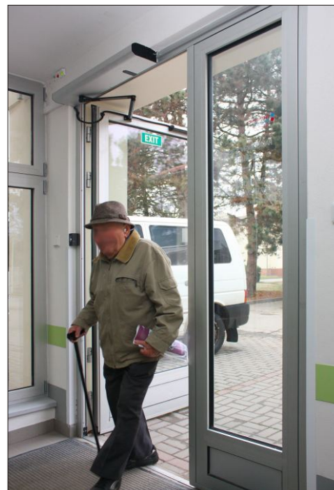
1-křídlové AD otočné - tlačné provedení, dveřní křídlo vybavené oboustranně bezpečnostní lištou;
