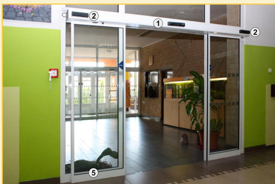
Všechny automatické dveře posuvné SPEDOS jsou vybaveny červeným **tlačítkem nouzového otevření** (4), které je instalováno buď na krytu pohonu vedle digitálního programového přepínače, nebo externě. Umožní okamžitě uvést dveře do bezpečné, otevřené polohy.
